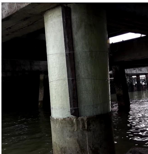
Gia cường, bảo vệ kết cấu (vật liệu dạng tấm)
