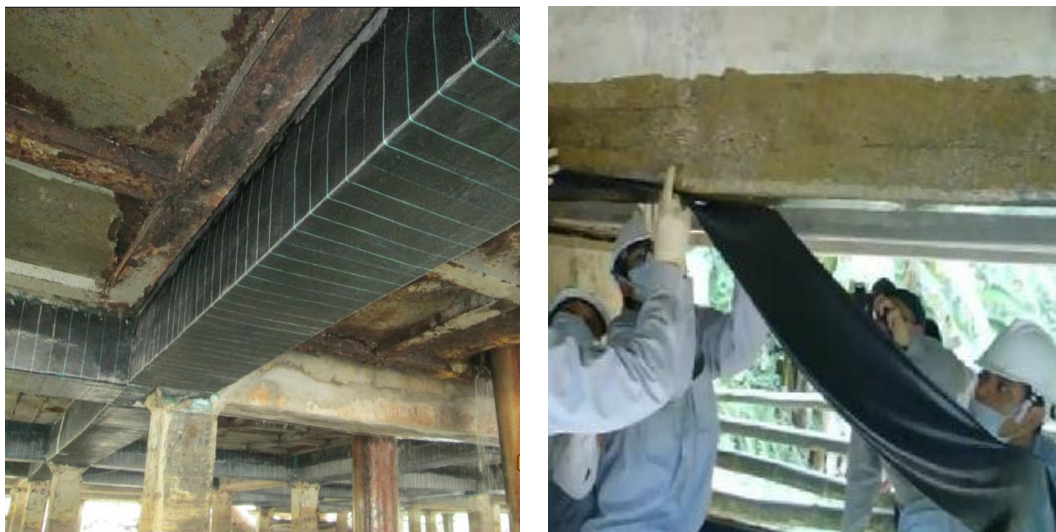
Gia cường, bảo vệ kết cấu (vật liệu dạng vải sợi)
