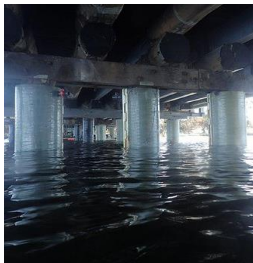
Gia cường, bảo vệ kết cấu (vật liệu dạng tấm)
